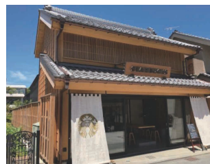
町並みルールに乗っ取った新築のスターバックス
