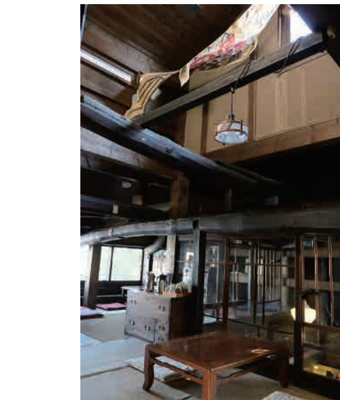
二階は天井を抜いて明かり窓をつけた
