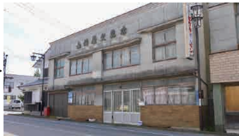
リノベーションする前の写真
