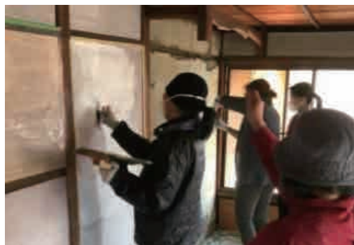
↑ワークショップで改修している様子（内壁の漆喰塗り）
