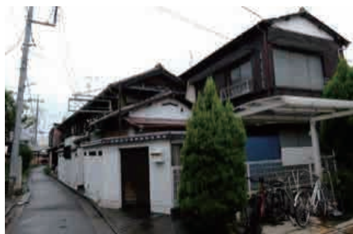
↑改修前の喜多町弁天長屋の外観。白い塀はほぼ無筋の老朽化したブロック塀
